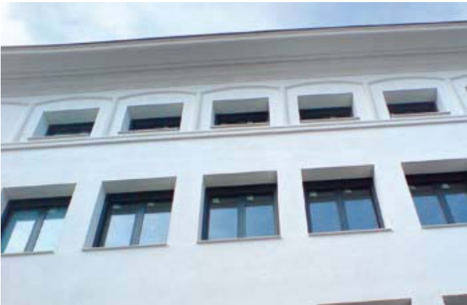
VISTA DEL EDIFICIO QUE ALBERGARÁ LA RESIDENCIA.
